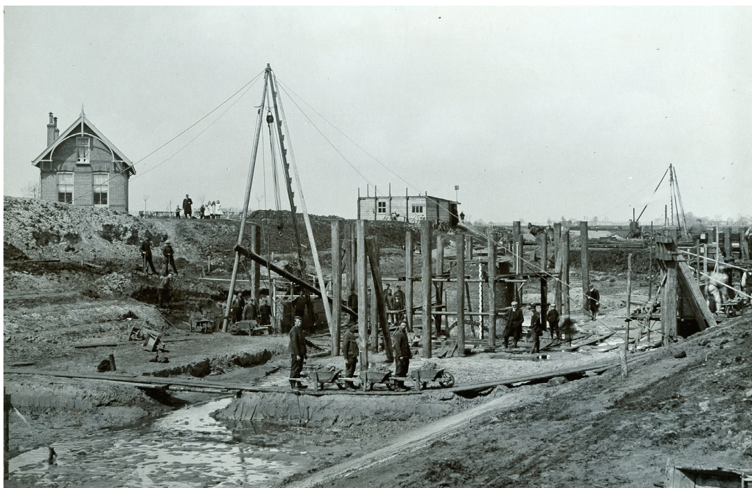
Brugwachterswoning en Wijmeersterbrug in aanbouw
