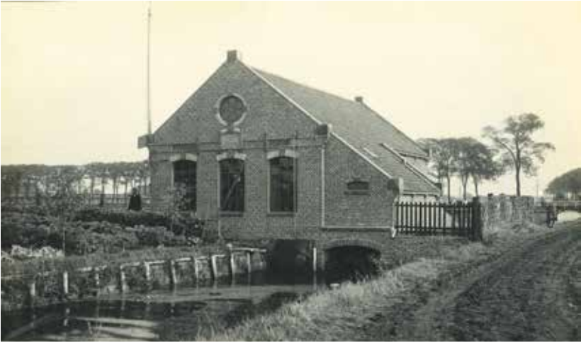
Gemaal De Hoogte Nieuwolda, 1928. Foto: onbekend, Waterschap Hunze en Aa's
